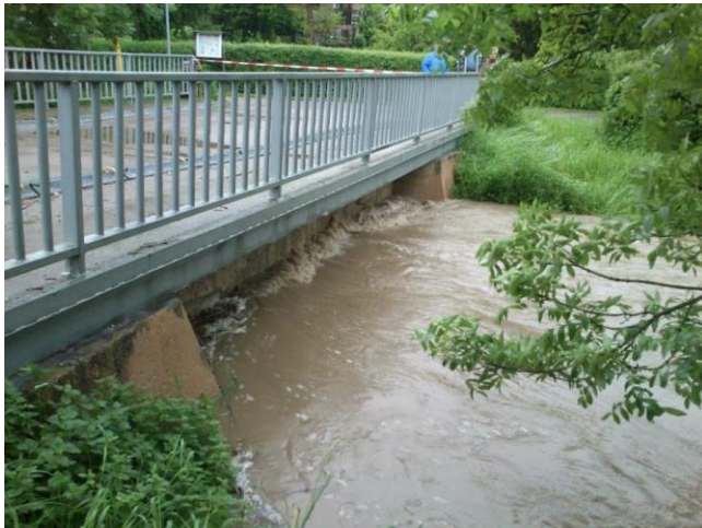
1: Brücke „Am Sulzenberg“
