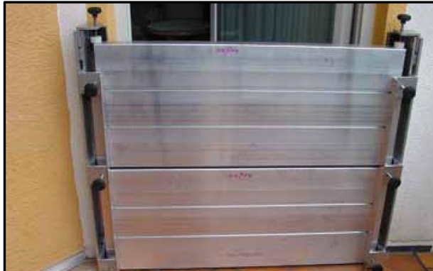
1: Objektschutz an Gebäudeöffnungen
