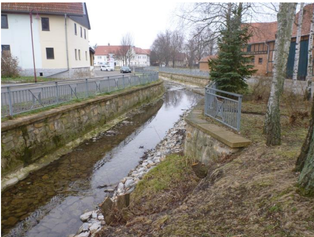
3: Ausgebautes Gerinne in Büßleben
