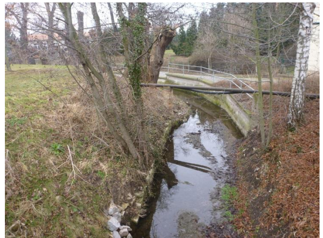
2: Rechte Ufermauer Rudolstädter Straße
