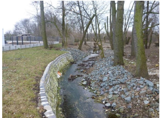
2: Uferbefestigung am Autohaus Gitter in Linderbach
