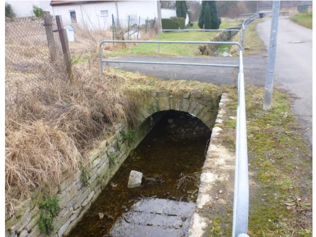
2: Kastengerinne mit Durchlass (bogenförmig)
