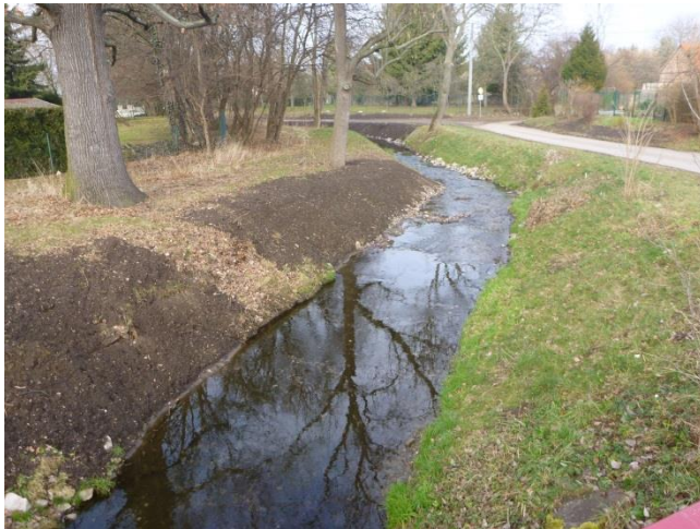
1: Gerinne unterhalb der Brücke „Im Ziegelgarten“
