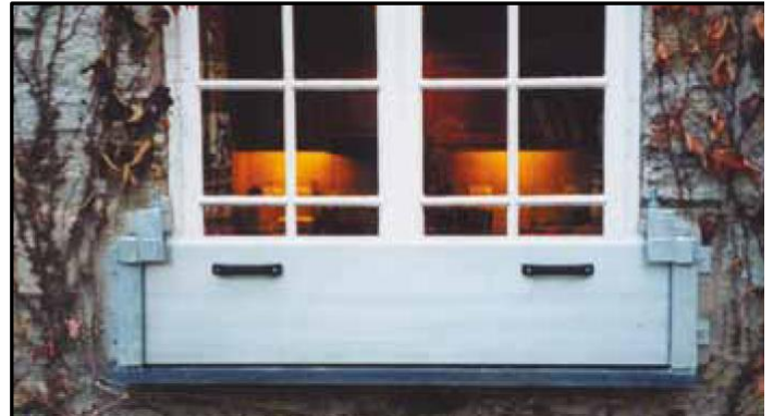
2: Objektschutz an Fensteröffnungen
